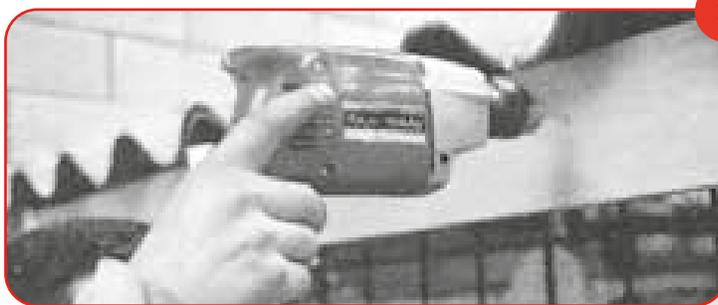
Alinee la parte superior de la "unión de canal bajante" con la cuerda y marque los agujeros sobre el muro; con el taladro abra los huecos, instale los chazos plásticos y atornille la unión al muro; y si es sobre madera, atornille directamente.
