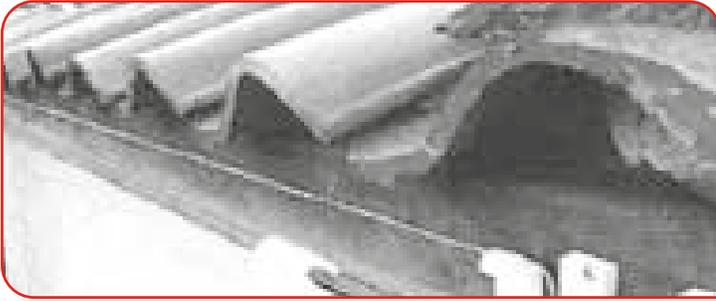
Si el muro está nivelado, tienda una cuerda desde el punto donde va iniciar la instalación, hasta el sitio donde ubicó la "unión de canal a bajante".
