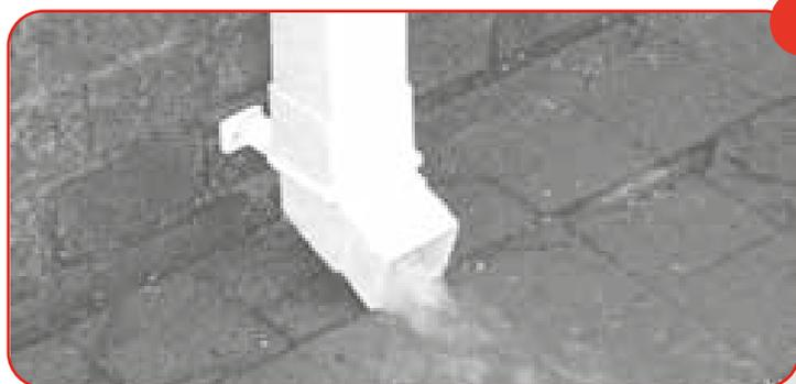
Acóplela a un codo soportado en la pared, para descargar las aguas lluvias al patio, al jardín, etc., o conéctelo al tubo de alcantarillado CELTA de 4" mediante el adaptador de bajante a alcantarillado CELTA o al adaptador bajante aguas lluvia de 3".
