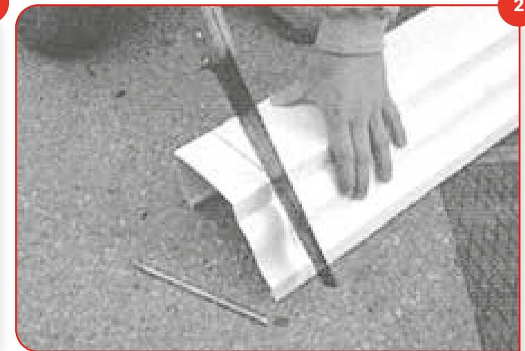
Para lograr cortes a escuadra, ajuste un soporte a la canal, marque el punto de corte, y desplace el soporte 3 cm. Sobre la marca, efectúe el corte con una segueta, retire las rebabas del corte y retire el soporte utilizado como ayuda.
