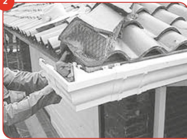
Si la instalación requiere "Unión Esquina" coloque soportes lo más cerca posible a dicha unión, ya que esta NO se atornilla al muro.
