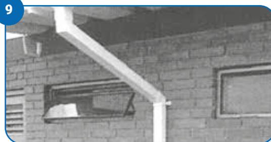
Para continuar la instalación corte los tramos de bajante a la longitud necesaria, deje 6 mm entre la bajante y la unión o codo, para la expansión térmica.
