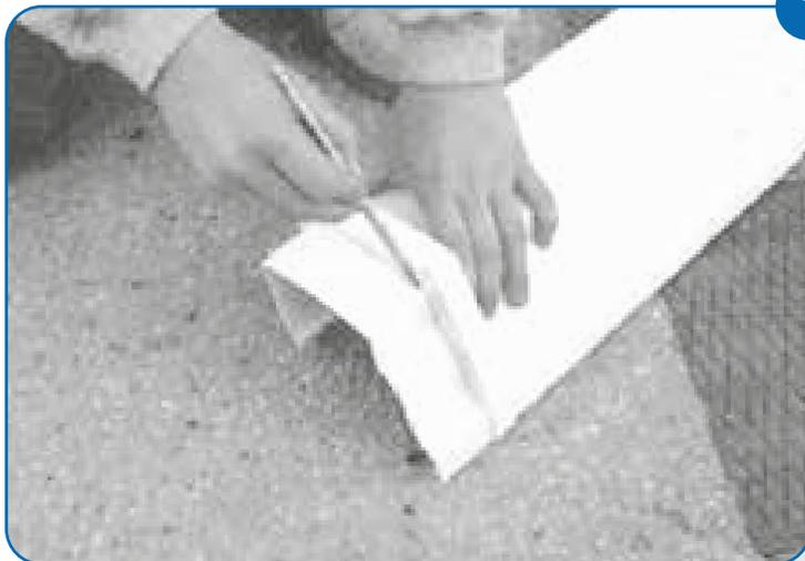
Para lograr cortes a escuadra, ajuste un soporte a la canal, marque el punto de corte, y desplace el soporte 3 cm. Sobre la marca, efectúe el corte con una segueta, retire las rebabas del corte y retire el soporte utilizado como ayuda.
