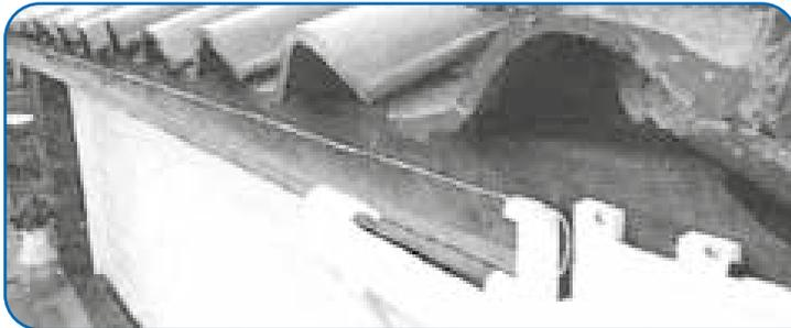
Si el muro está nivelado, tienda una cuerda desde el punto donde va a iniciar la instalación, hasta el sitio donde ubicó la "unión de canal a bajante".
