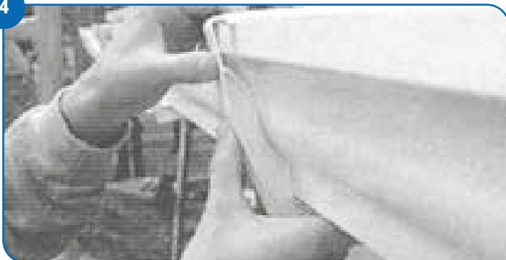
● Inicie la instalación en un accesorio comprobando que la canal llegue hasta la marca indicada en la parte interna del mismo.
