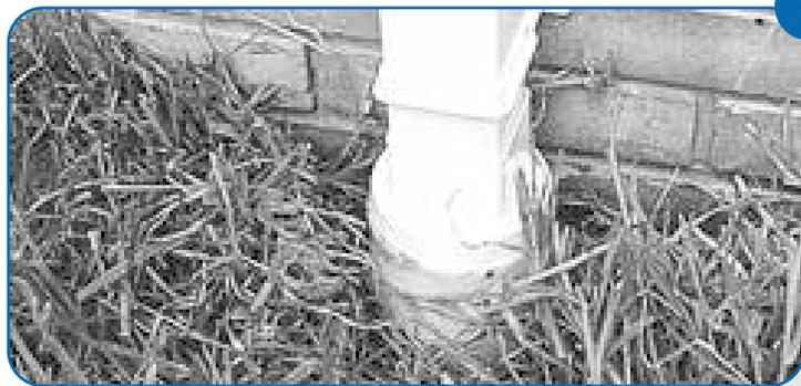
Acóplela a un codo soportado en la pared, para descargar el agua lluvia al patio, al jardín, etc., o conéctelo al tubo de alcantarillado CELTA de 4" mediante el adaptador de bajante a alcantarillado CELTA o al adaptador bajante aguas lluvia de 3".
