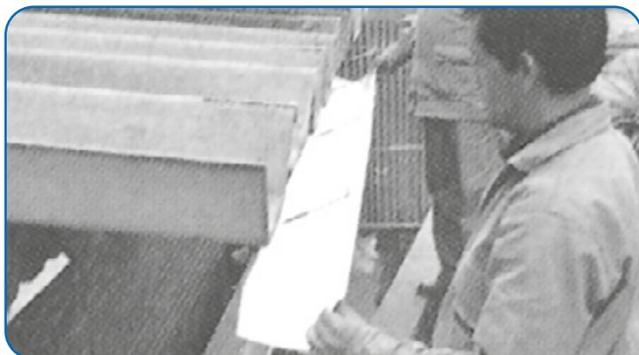
Marque la platina del soporte metálico a la misma altura del primer soporte ya instalado, manteniendo la pendiente. Doble e instale.
