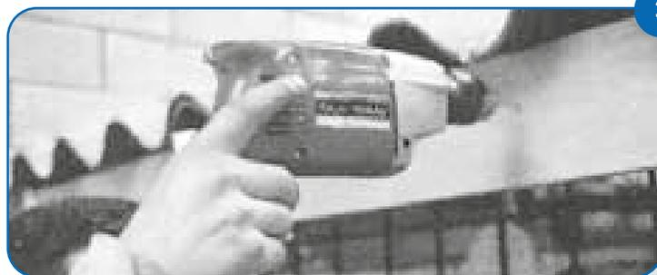
Alinee la parte superior de la "unión de canal bajante" con la cuerda y marque los agujeros sobre el muro; con el taladro abra los huecos, instale los chazos plásticos y atornille la unión al muro; si es sobre madera, atornille directamente.
