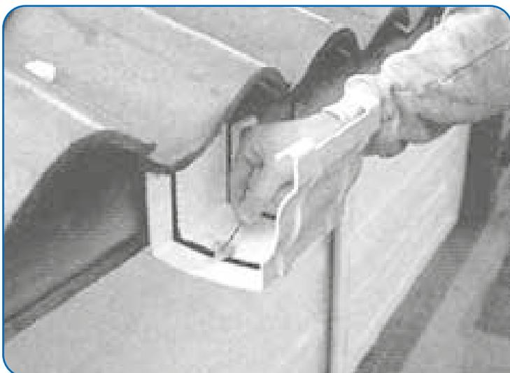
● Aplique generosamente lubricante de silicona a todos los sellos de caucho de los accesorios, para facilitar el ensamble de la canal y permitir la dilatación y contracción de la misma.
